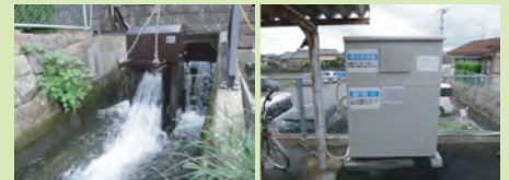
病院の小水力発電機連係設置例
