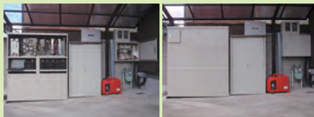
住宅エンジン発電機連係設置例
